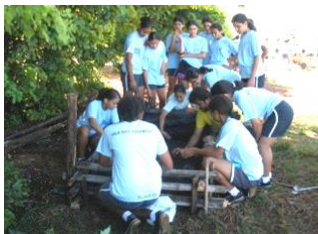
Construção do minhocário
