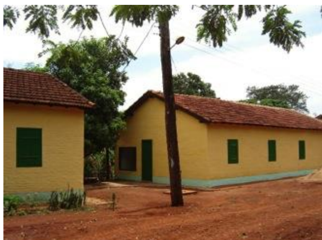
Alojamentos – vista externa
